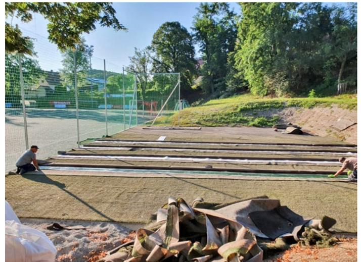
Betonbordsteinen gesetzt sowie eine erste Lage Frostschutzmaterial eingebaut und verdichtet. Parallel dazu wurden die Pfosten für den Ballfangzaun durch die Firma **Metallbau Vogel** errichtet.
